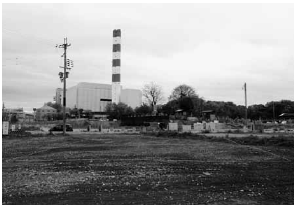
図3 調査前全景 (南西から)
