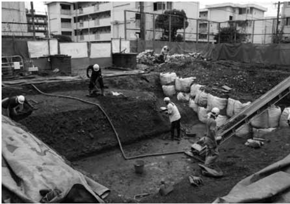
図5 3区作業状況（北西から）
