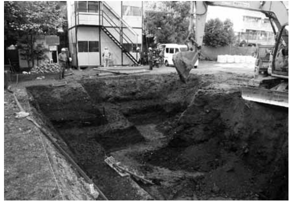
図4 1区重機掘削状況（南から）
