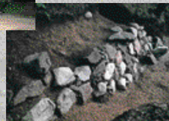
5で検出した石垣は、北堀ののり面に積まれたものです。高石垣ではなく、のり面の裾を押さえる目的の石垣と思われます。
