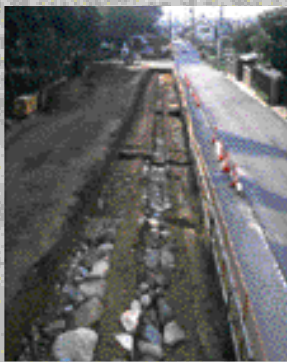
3 上板橋通り(東から) 上板橋通りの拡幅工事で、路面と側溝・石垣が約170mにわたって検出されました。
