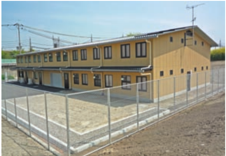
伏見水垂収蔵庫の外観
