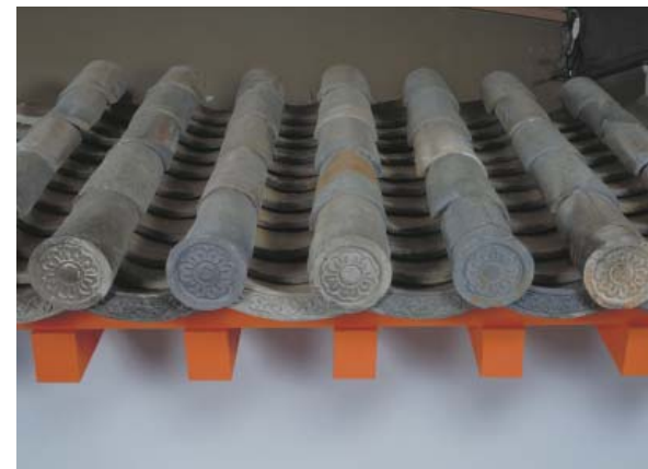
鳥羽離宮金剛心院出土瓦による屋根葺上げ復元
