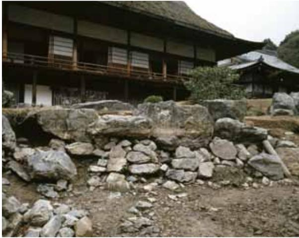
写真2 修理前の護岸石下部の積石（南西から）
