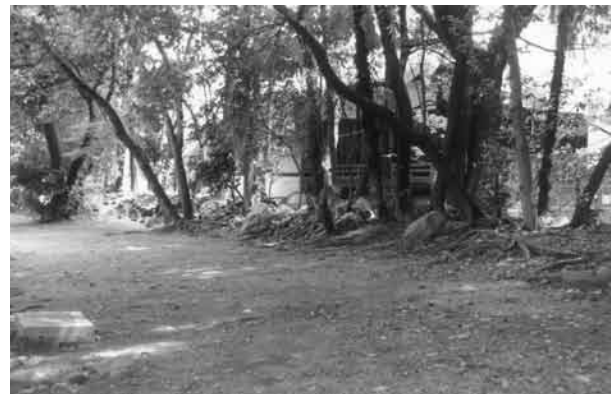
図114 石垣調査前（南西より）
