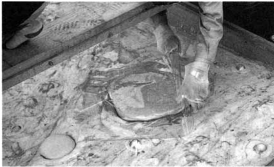
図 112 ウレタン樹脂を柱に充填
