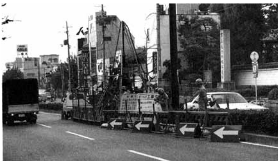
図89 ボーリング調査風景
