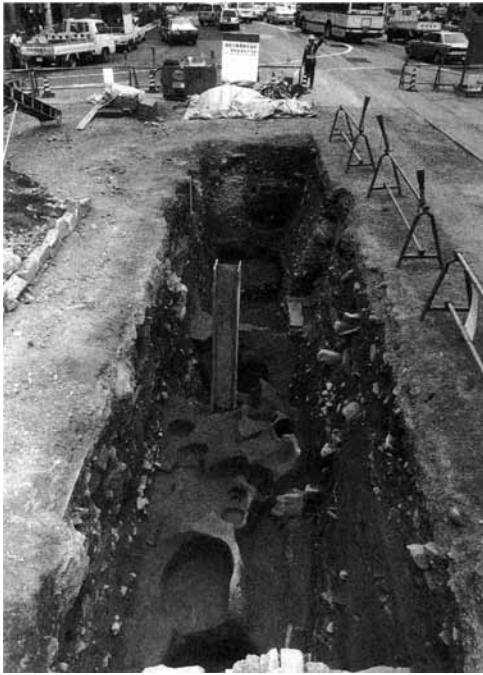
図 106 T-No.8 トレンチ全景 (東から)
