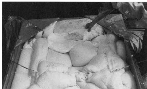
図117 全体的に発泡ウレタン樹脂を注入
