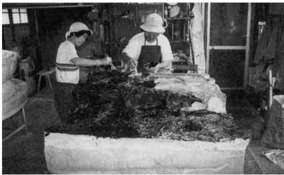
図 119 FRP樹脂1層目を塗布
