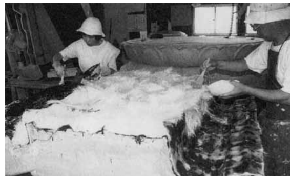
図 120 樹脂2・3層目はガラス繊維を貼り込む
