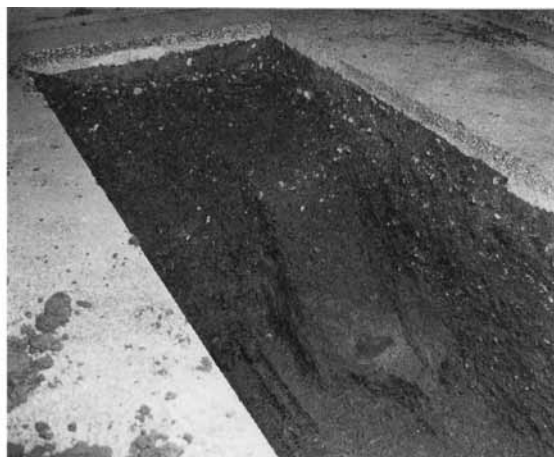
図 91 大極殿基壇 (北東から)
