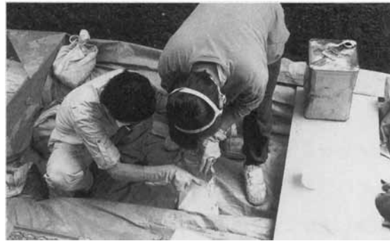
図114 部分的に発泡ウレタン樹脂を注入
