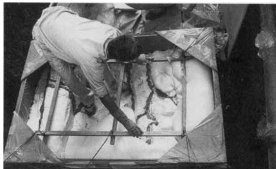
図116 木組みを型枠内に入れる
