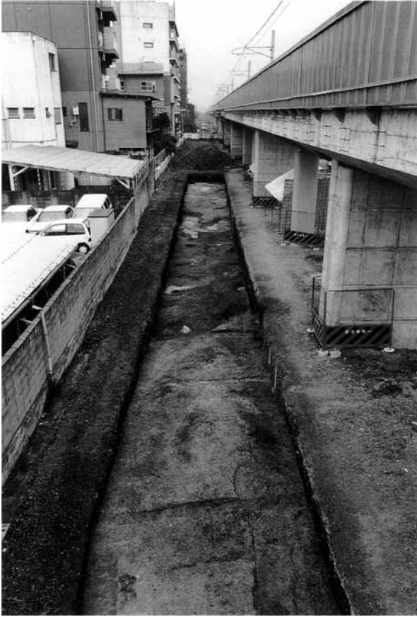
1 5A区全景（西から）
