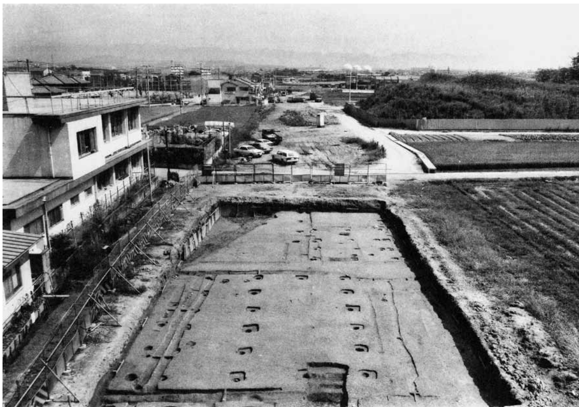
1 長岡京跡 K 区全景 (西から)
