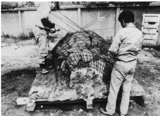
石組の外側を鉄筋で固定する作業
