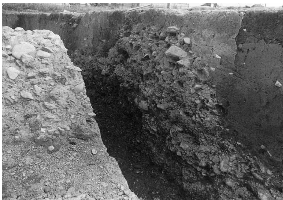
4-1・2 トレンチ石積遺構1 立ち割り断面（南東から）
