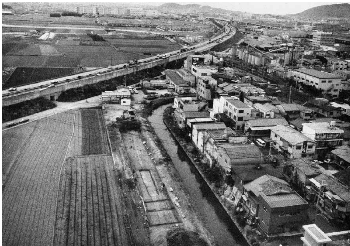
1 全景・バルーン撮影（北から）
