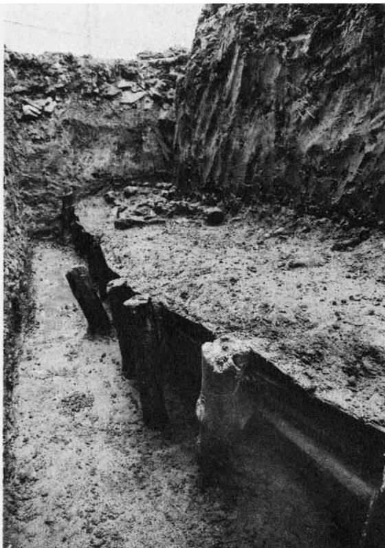
2 B区 No.25 地業東肩土留 (北から)
