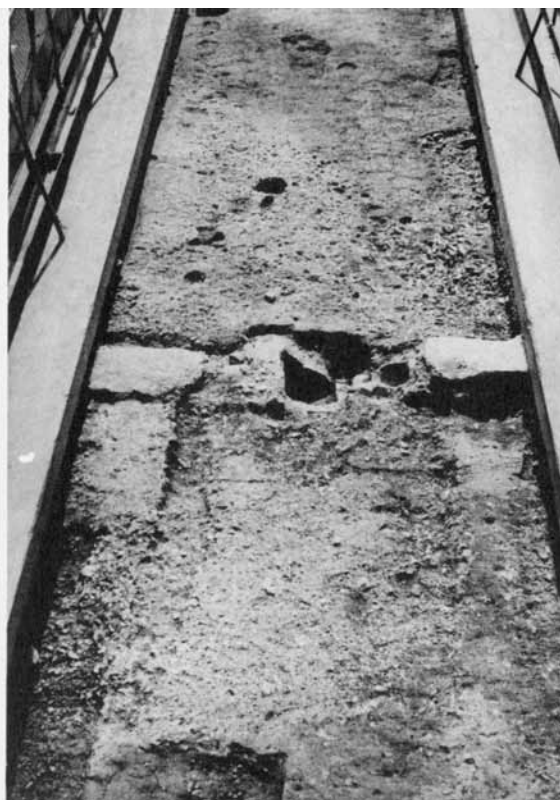
3 No.93 トレンチ全景 (東から)
