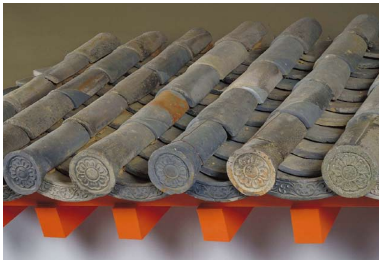
写真1 金剛心院出土の播磨系瓦による屋根葺上げ復元
