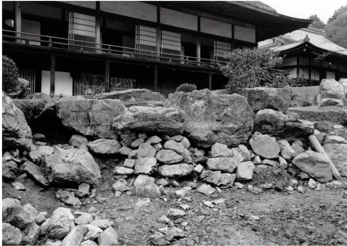
写真1 池護岸の天端石と積石
