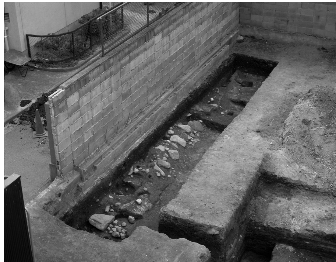
尊勝寺西塔跡の地業（北東から）『昭和59年度京都市埋蔵文化財調査概要』 西塔北側で検出した地業は大きな石材を大量に埋め込むもので、法勝寺八角九重塔の地業と共通する。
