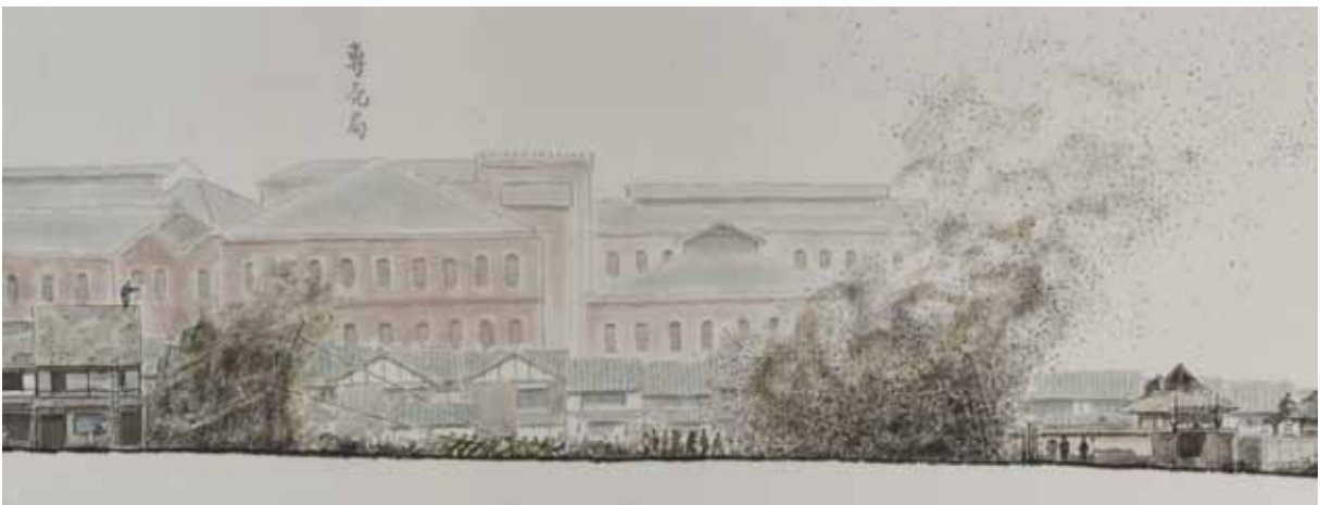
写真 6. 「五条坂南側町並散華の図」 第 2 扇（建物を引き倒し、粉塵が舞い上がる）
