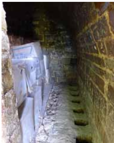
図12 狭間穴の吹出し口（縦）
