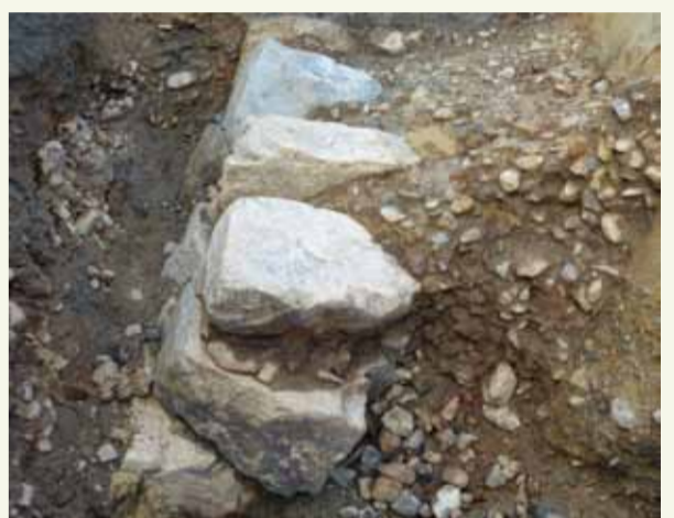
本丸南面(東から)石垣の様子
