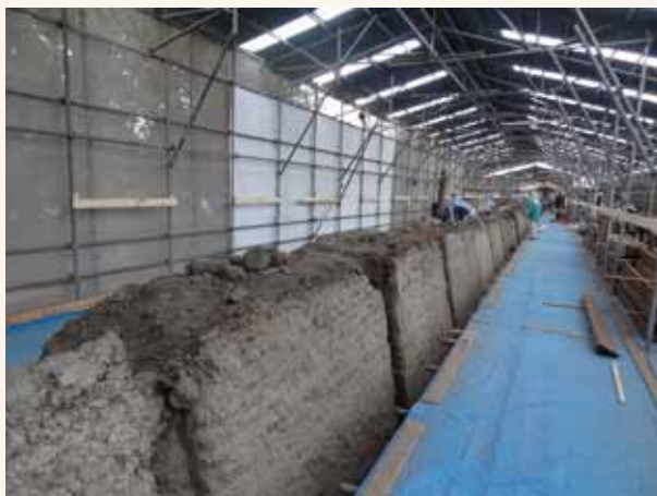
東築地塀本体の調査
