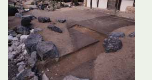
護岸石の掘え付けの様子
