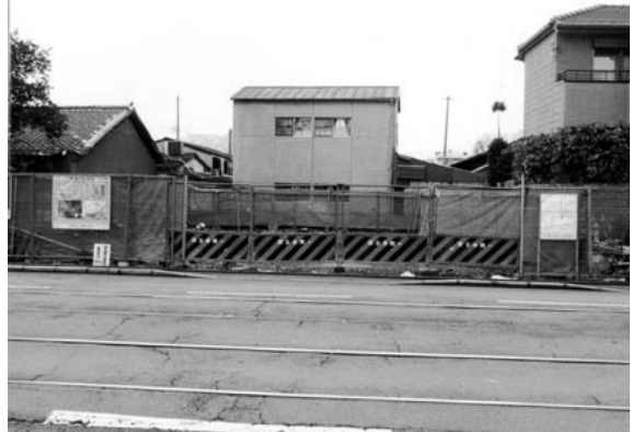
図20 1区調査前全景（南から）
