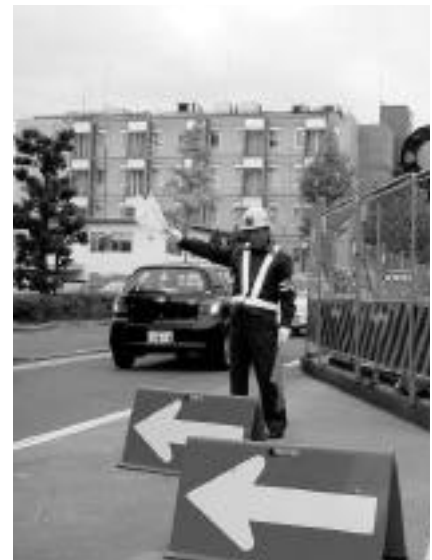
写真1 調査区の安全対策
