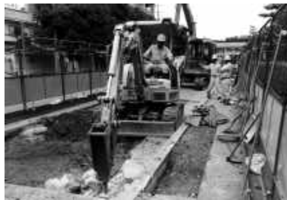
図3 A区調査状況
