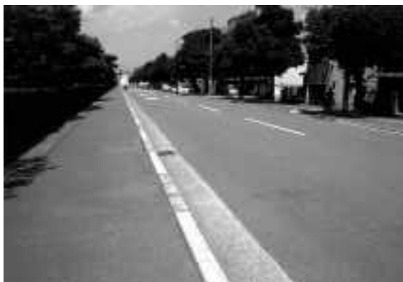
図2 調査前全景(南東から)
