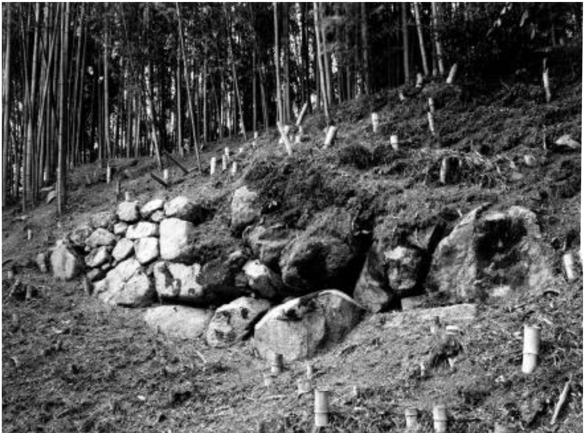
2 境内南斜面に露出する石垣（南東から）
