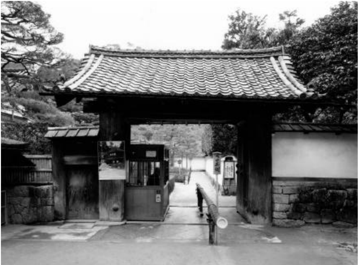
2 A区 解体前中門（西から）
