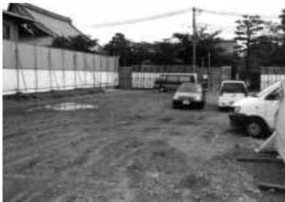
図2 調査前全景（西から）
