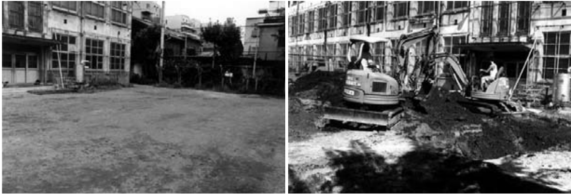
写真1 試掘調査風景（左は調査前の状態、南西から、右は掘削風景、南東から）
