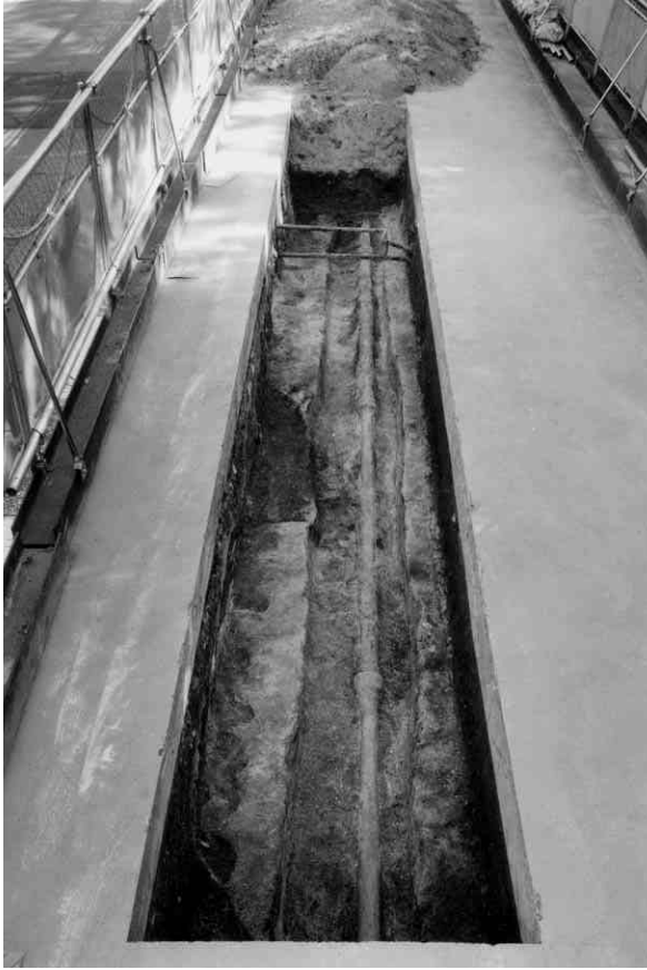
1 A区T1全景(北から)
