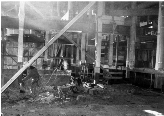
図3 調査前全景（北から）
