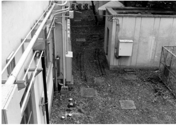
図3 調査前全景（東から）
