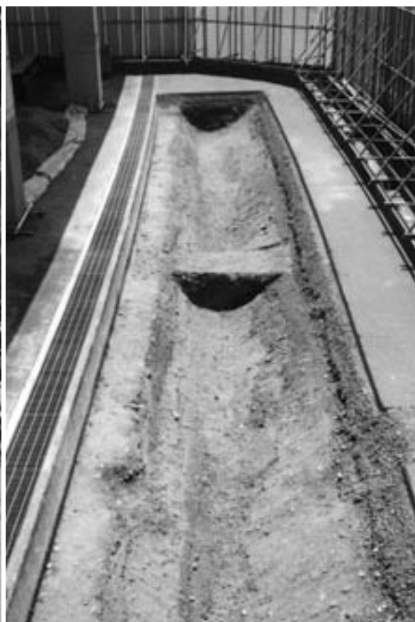
2 遺構掘削後全景（北から）
