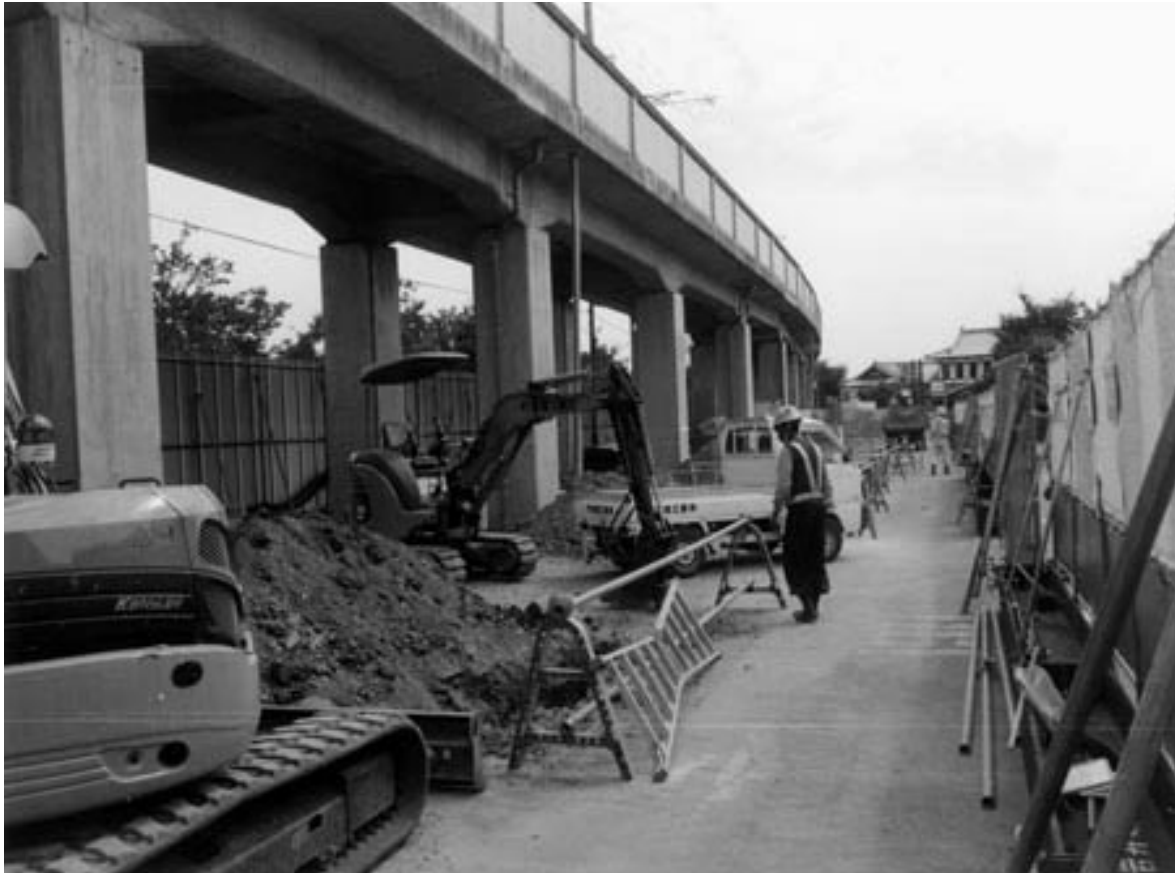
1 調査地全景（北から）
