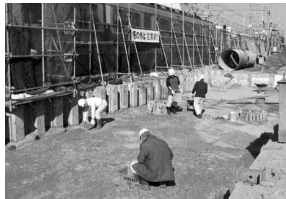
図 20 B 4区調査風景(南西から)
