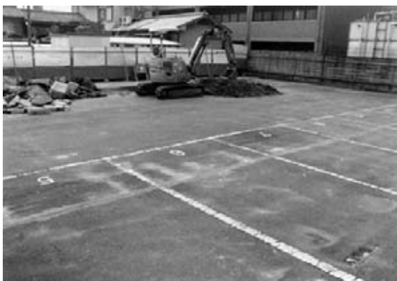
図4 調査前全景（北西から）
