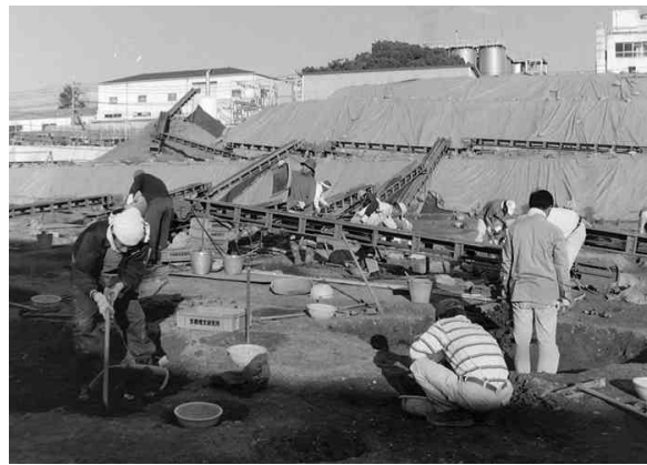
図4 作業風景（南西から）
