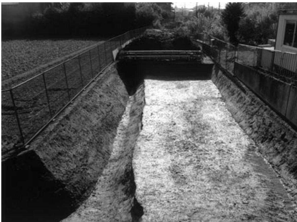
1 1区北半全景（北から）
