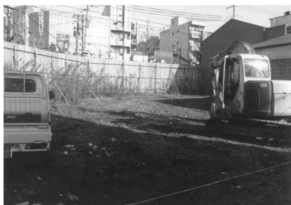
図1 調査前全景（南西から）
