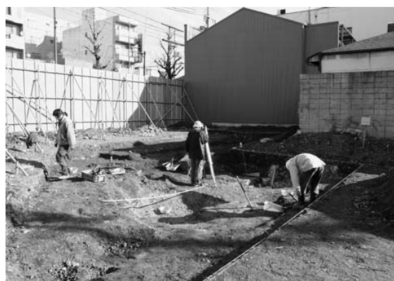
図2 作業風景（南西から）
