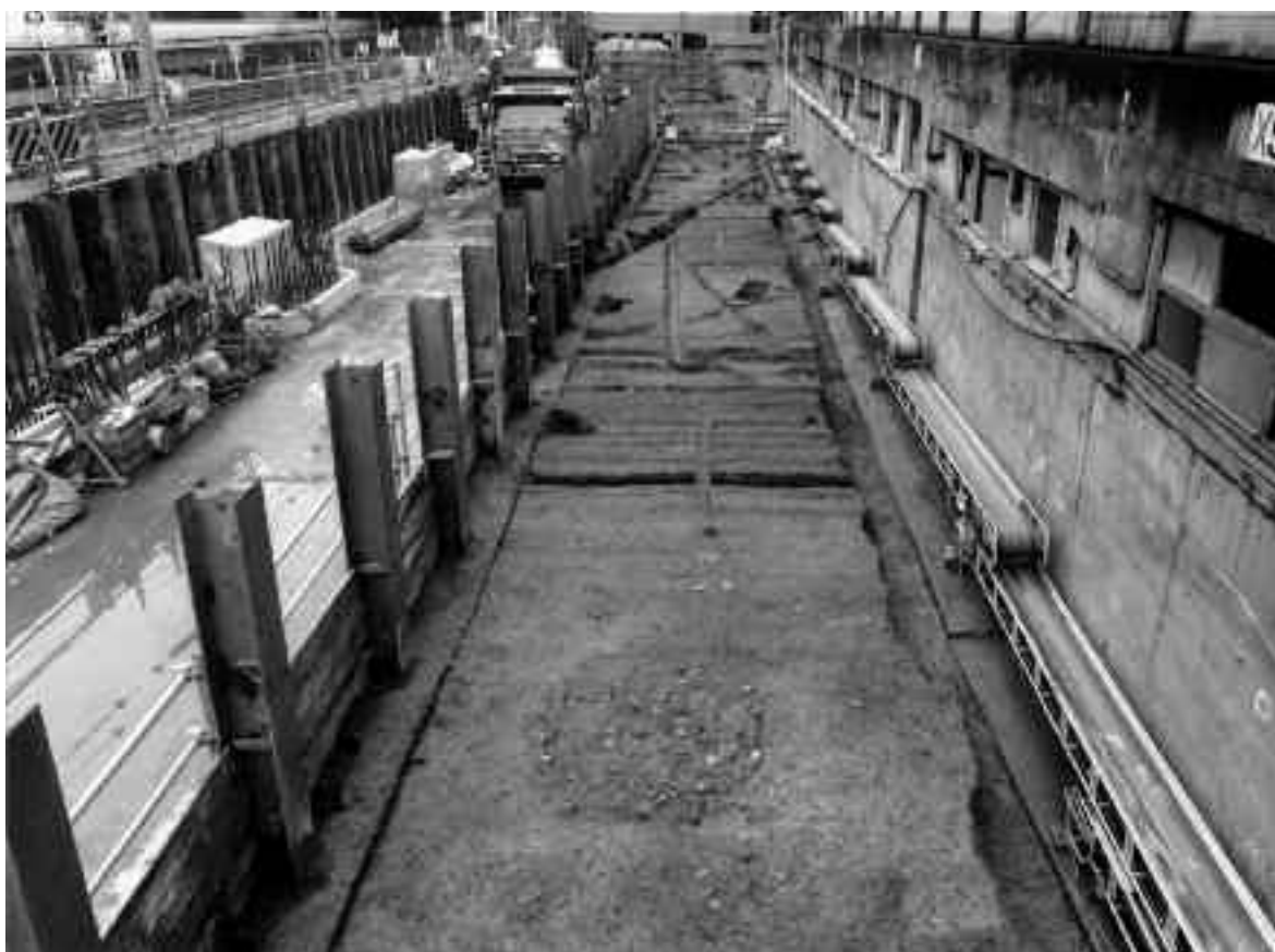
2 1区南西 第1面全景（西から）
