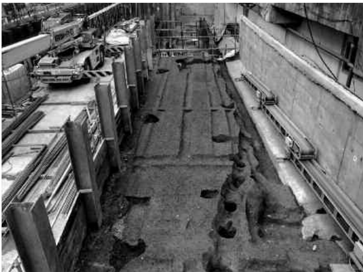
1 1区南中 第1面全景（西から）
