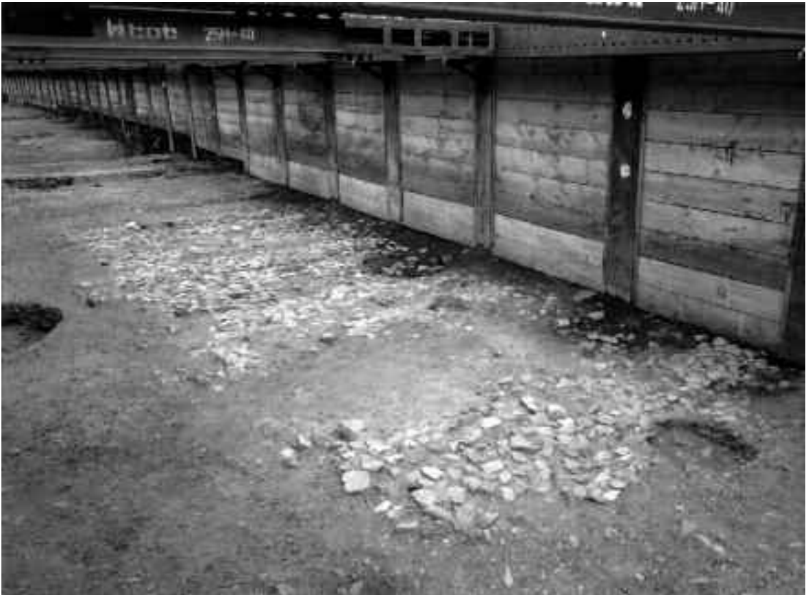
2 3区北 泉241 (北西から)
