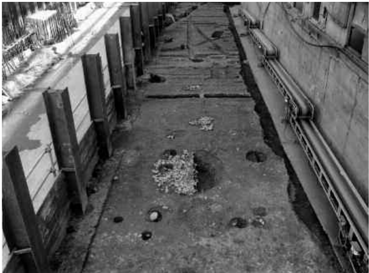
2 1区南西 第2面全景（西から）
