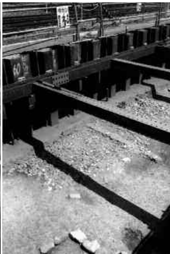
3 1区 建物146地業 (南西から)
