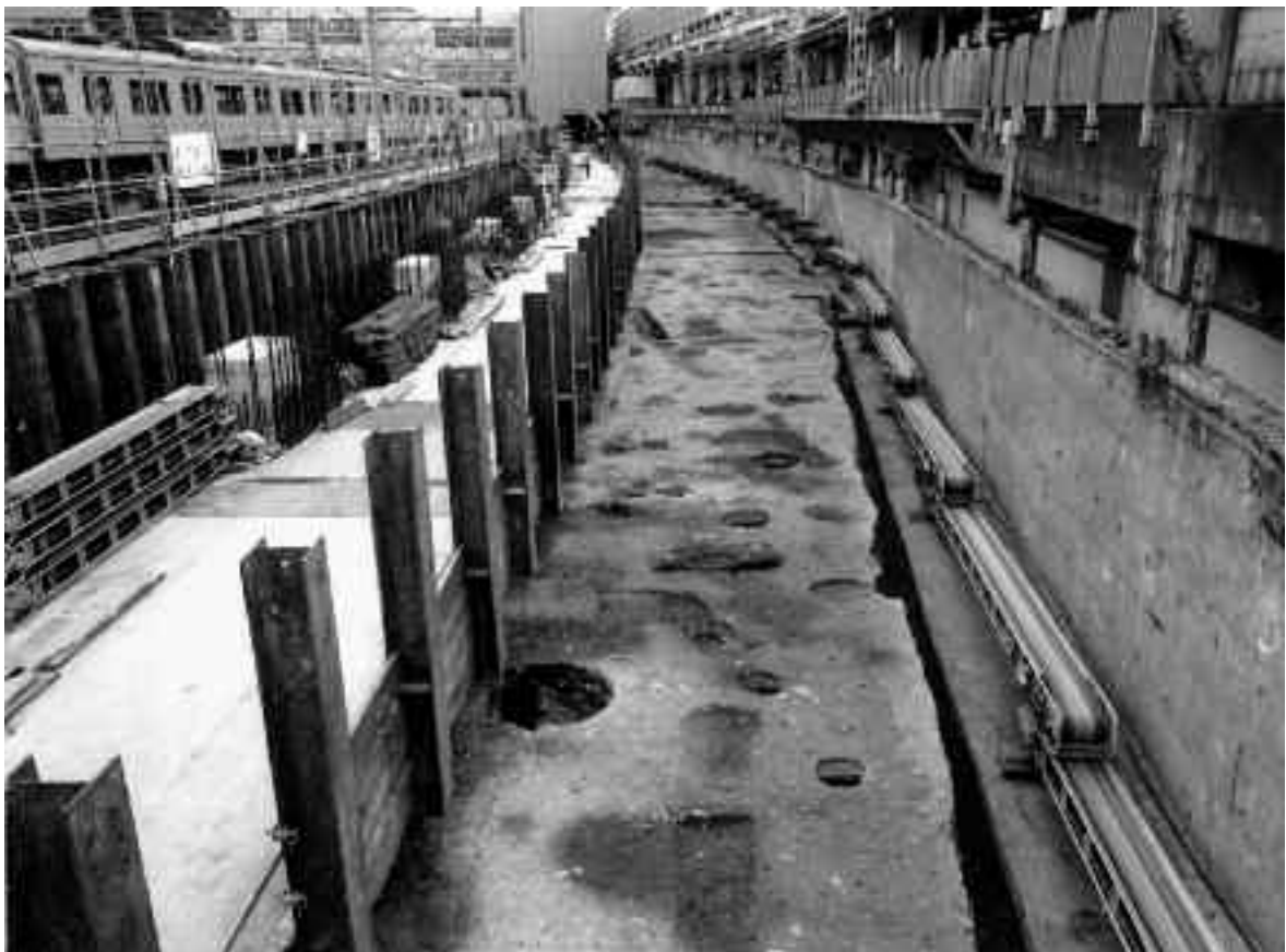
2 3区南 第2面全景（西から）
