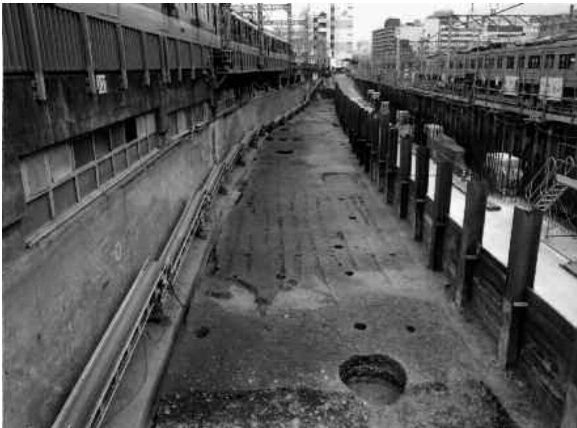
2 3区南 第1面全景（東から）
