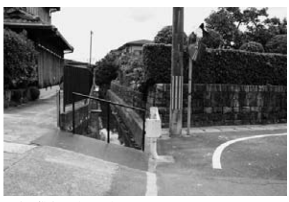
北東隅推定地 (北から)
