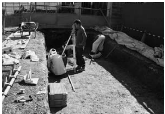
図4 2区作業風景（西から）
