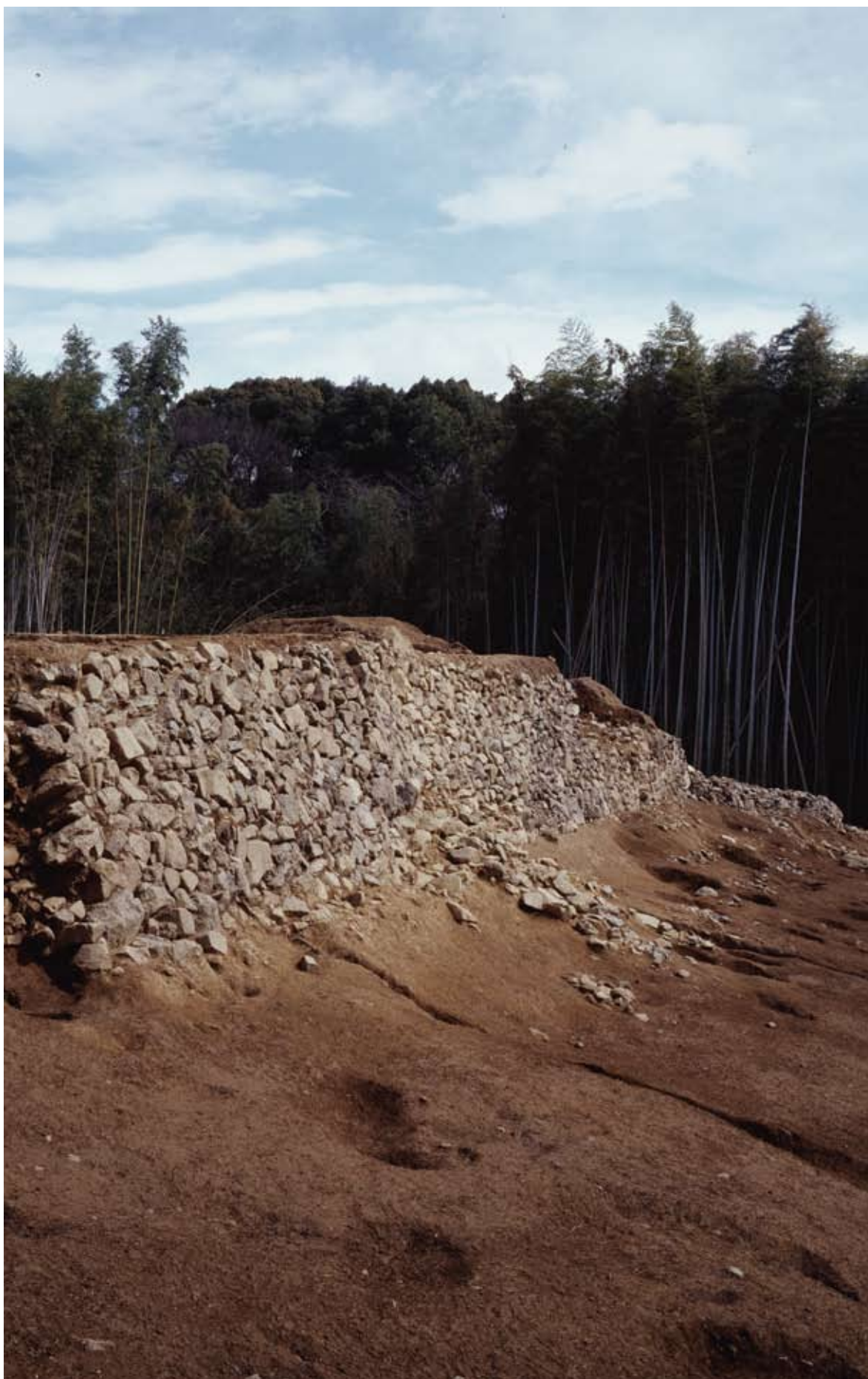
石垣 65 全景 (南西から)
