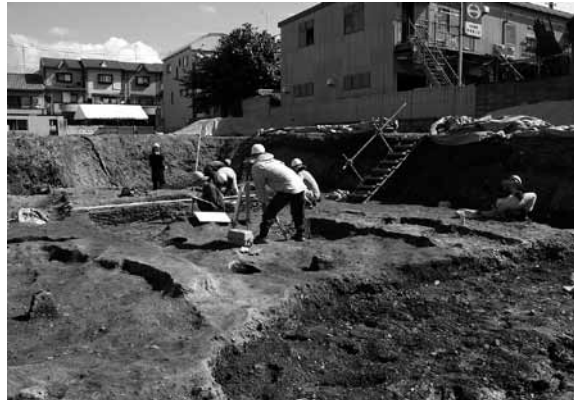
図3 作業風景（南西から）
