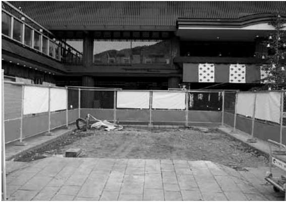
図3 調査前全景（西から）
