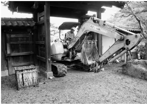
図4 1区重機搬入風景（北西から）
