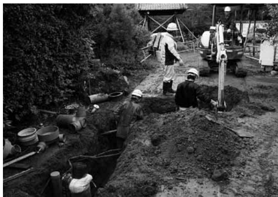
図35 立会No.4地点の配管作業風景(東から)
