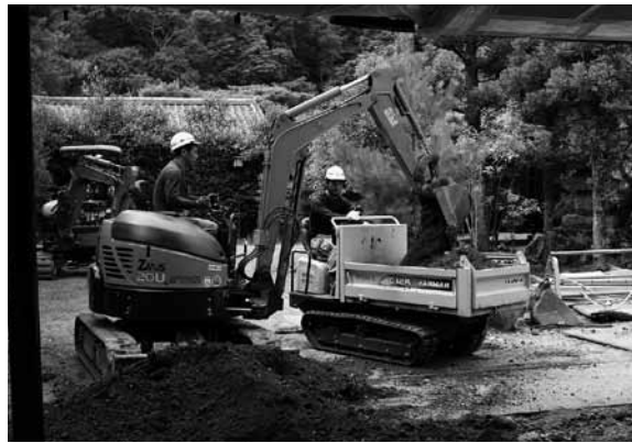
図5 3区重機掘削風景（北東から）
