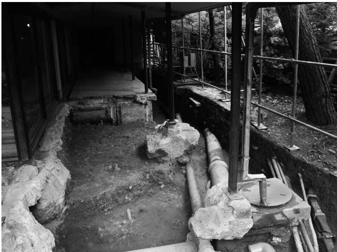
1 3区第1面全景（南から）
