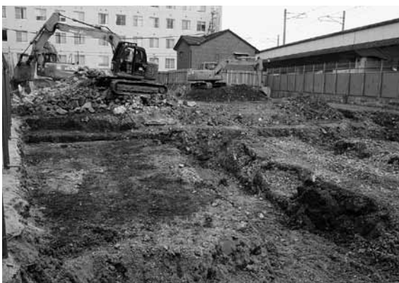
図3 調査前全景（北西から）
