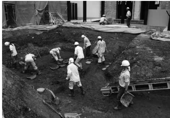
図5 作業風景（南東から）
