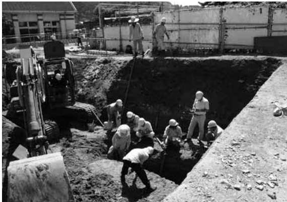
図6 断割作業風景（北西から）
