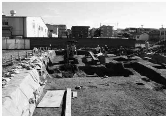
図4 作業風景 (西から)
