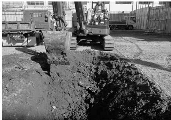
図4 重機掘削 (南から)
