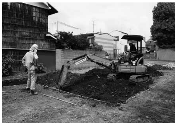
図4 重機掘削状況 (南東から)
