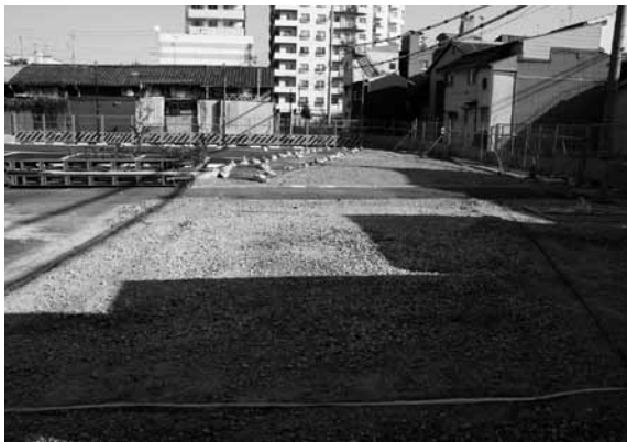
図3 調査前全景 (南から)
