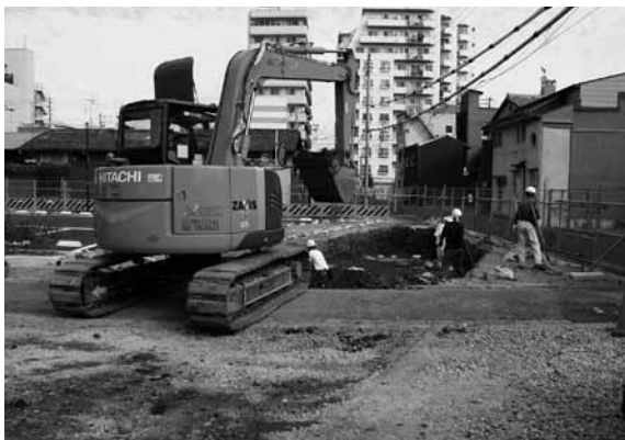
図5 重機掘削風景 (南から)
